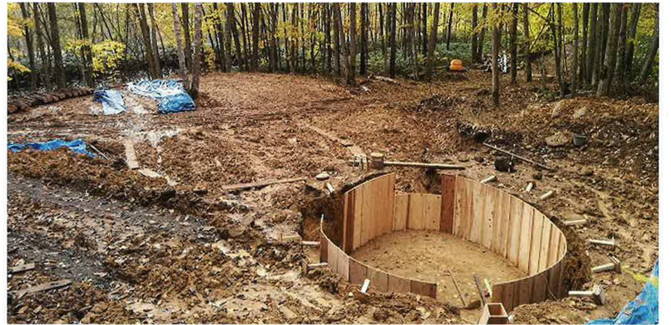
造成途中の炭窯。昔ながらの土と石だけで作る。
