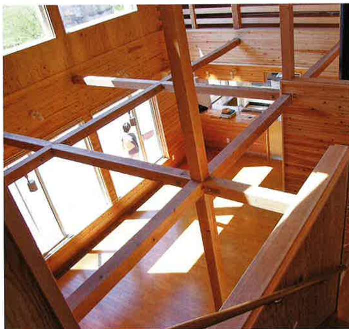
カラマツ乾燥材(無垢材)を構造材として使った住宅。
