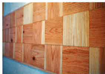
道南スギを使った(株)ハルキの壁材は、入居後に自ら施工。
