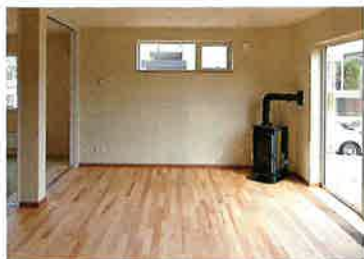
道産カバ材のフローリングが敷かれた居間には、ペレットストーブを設置。
