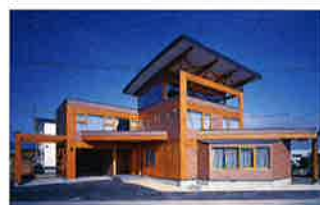
カラマツ大断面集成材を使用した、平成7年施工の3階建て住宅。
